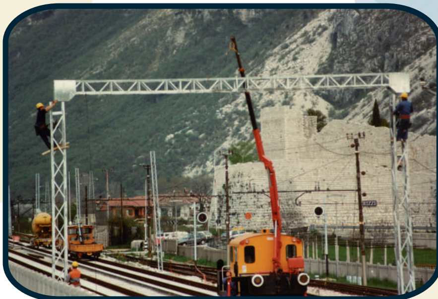
Venzone (UD), 1988 Laying of a gateway
